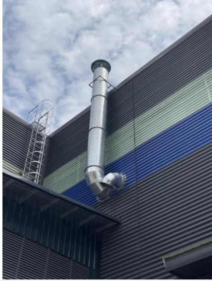
固化烘烤燃烧天然气废气排气筒 (DA002)
