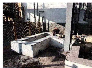
图 15 南铝废水二站排放口
